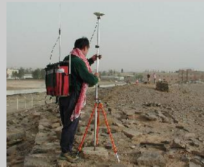
Travaux de mesure topographique au GPS
